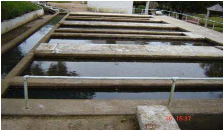
Ilustração 20 - Conjunto de pequenos tanques de filtragem
