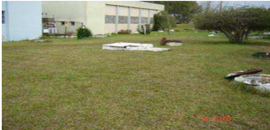
Ilustração 41 - Local onde estão os reservatórios enterrados R6, R6I e R62
