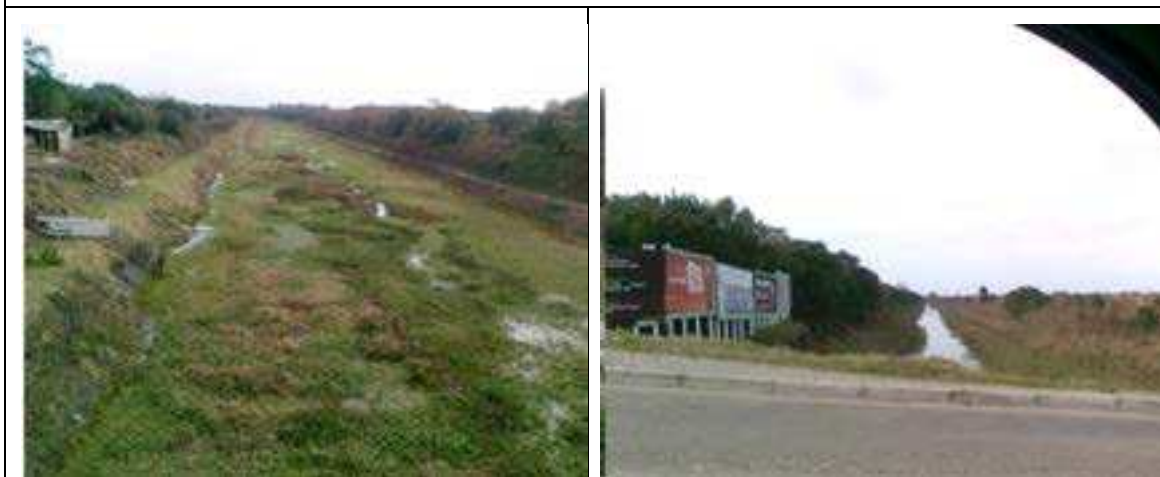
Figura 25: Canal Santa Bárbara e Canal Lateral da Margem Direita
