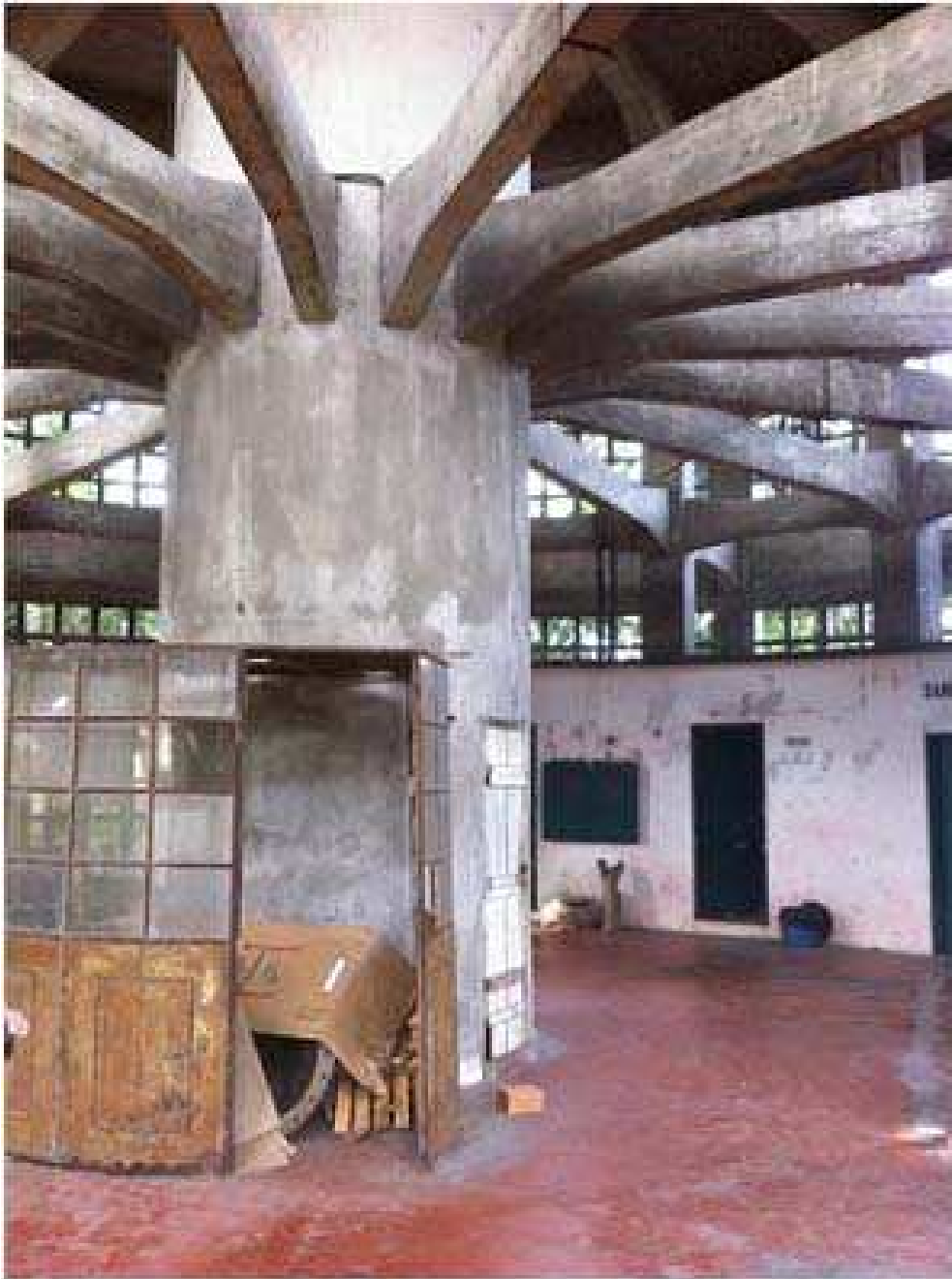
Ilustração 03 – Interior do Reservatório R4.
