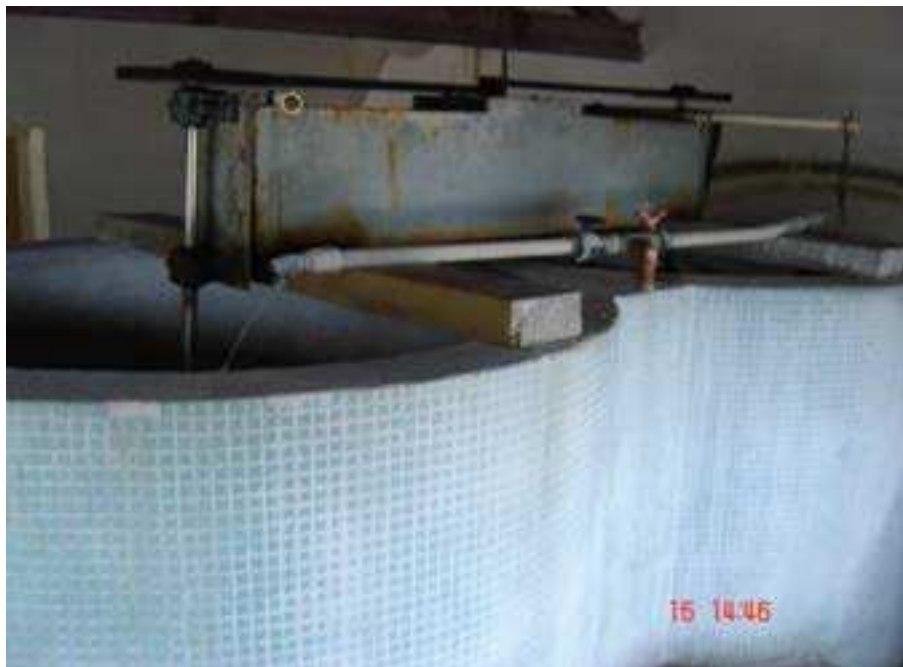
Ilustração 27 - Misturador de flúor
