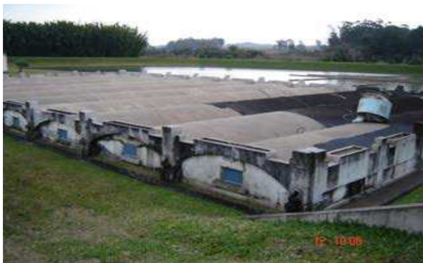
Ilustração 10 - Reservatório de água tratada com capacidade de 8.000 m 3
