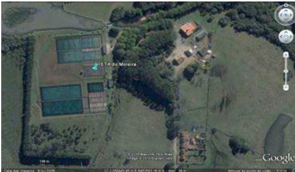
Ilustração 1 - Vista aérea ETA do Moreira
