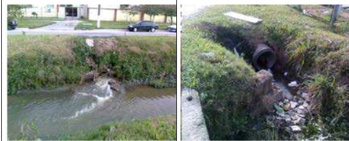
Figura 12: Microdrenagem descarregando na macrodrenagem
