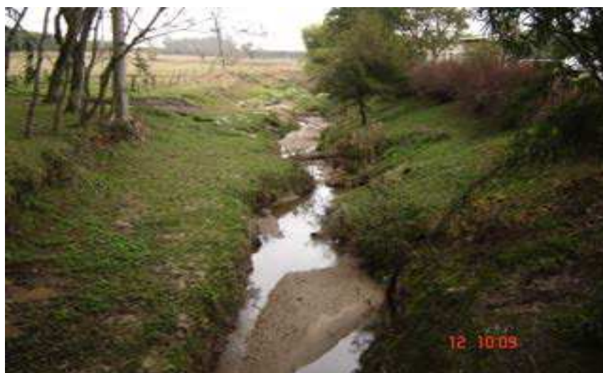
Ilustração 11 - Adutora de 305mm cruzando o canal extravasor da barragem
