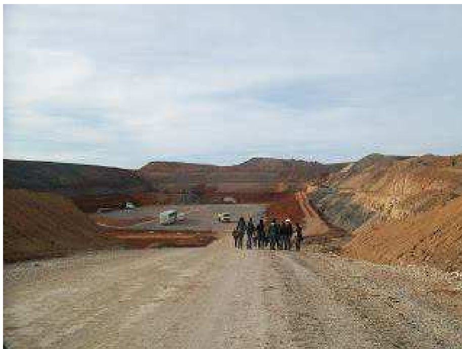
Figura 3.42 – Vista do aterro sanitário Candiota
