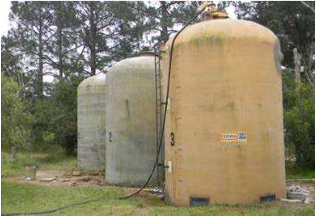
Ilustração 42 – Tanques de PAC
