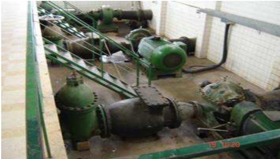
Ilustração 48 - Vista parcial da casa de bombas
