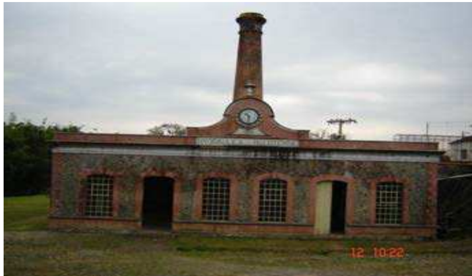
Ilustração 2 - Casa de Bombas e Museu do Moreira
