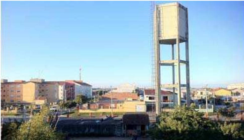
Ilustração 017 – Vista do Reservatório localizado no bairro Jardim das Tradições.
