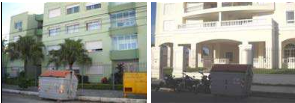
Figura 3.11 e Figura 3.12 – Situação após a implantação
