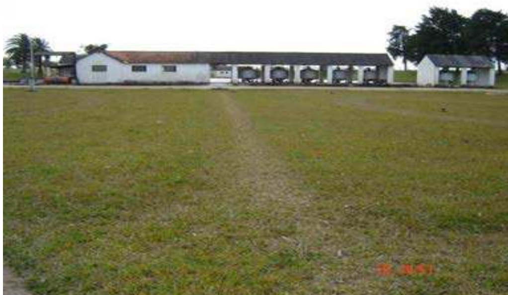
Ilustração 28 - Local do reservatório enterrado com 8.000m 3
