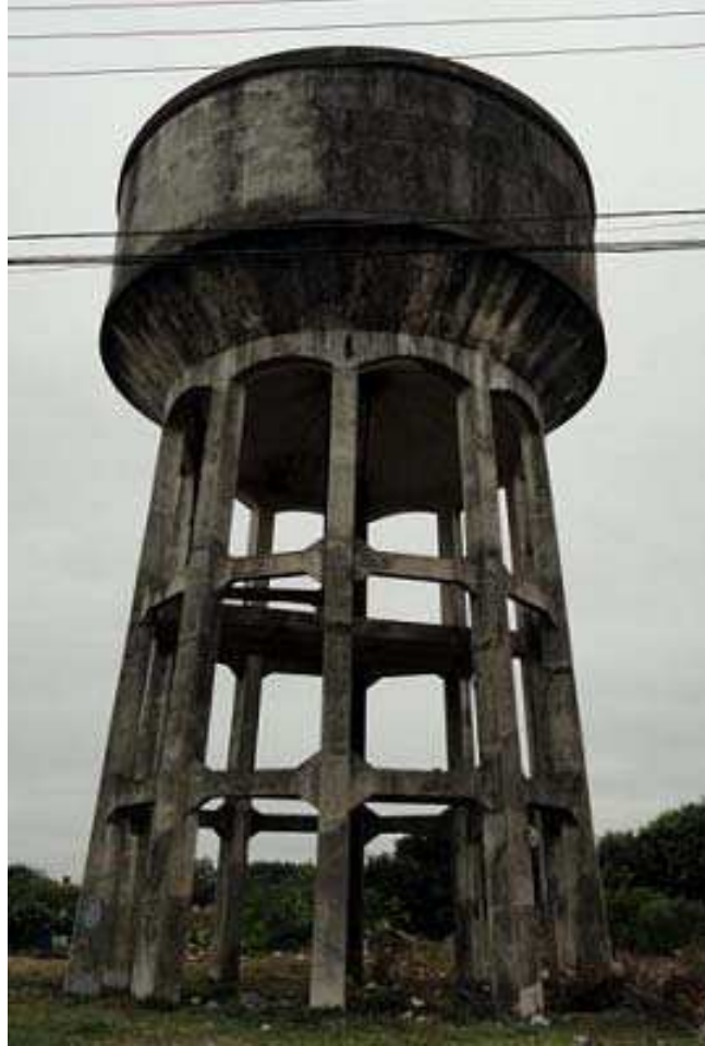
Ilustração 05 – Vista frontal do Reservatório R7.
