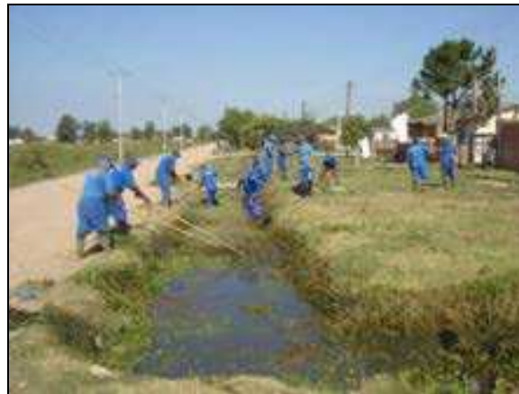
Figura 3.33 – Limpeza de valetas
