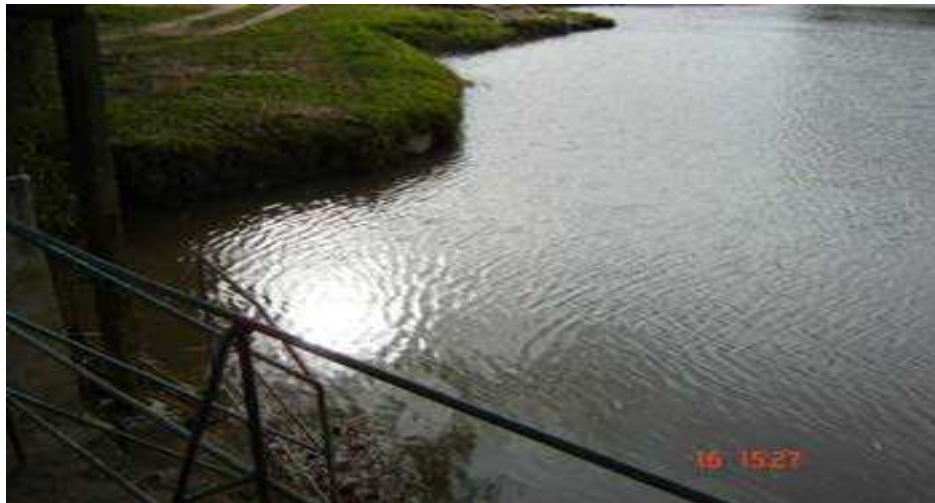
Ilustração 16 - Tomada de água Arroio Pelotas
