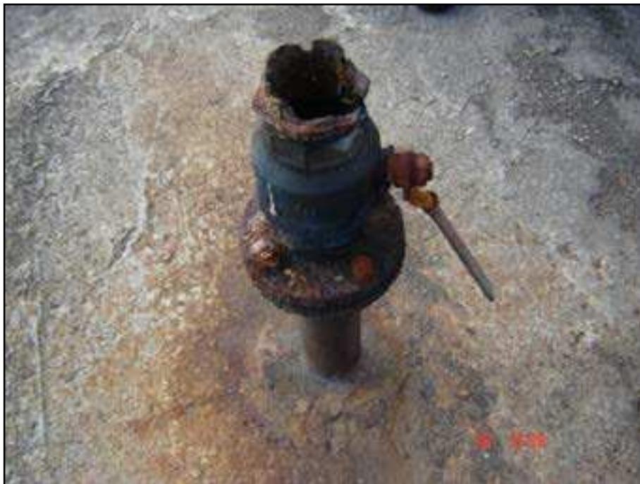
Figura 21 - Queimador de gás desativado (Fonte STE)
