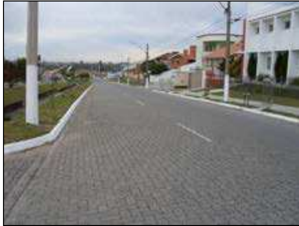
Figura 3.31 – Meio-fio após serviço de pintura
