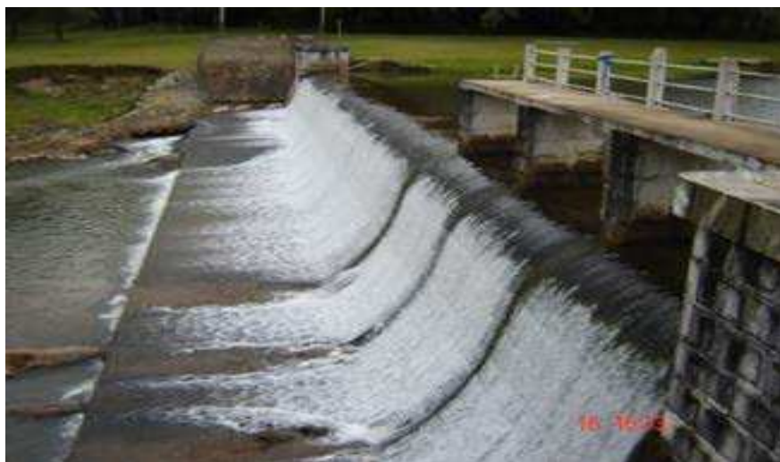
Ilustração 19 - Represa do Quilombo vendo-se no primeiro plano, peça de acionamento das comportas e no fundo a estrutura de contenção empuxos de terra.
