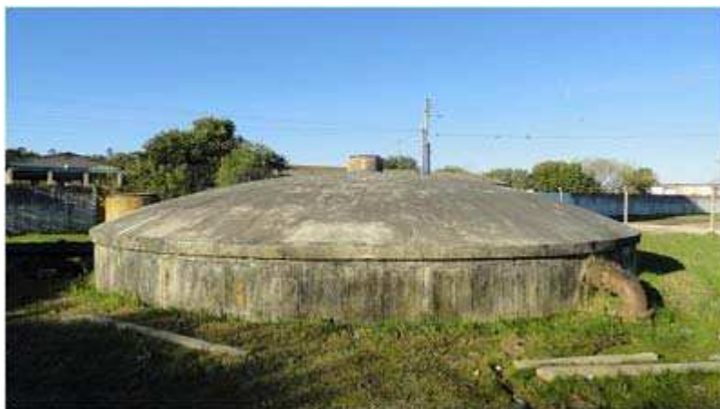
Ilustração 09 – Vista frontal do Reservatório inferior, semi-enterrado.
