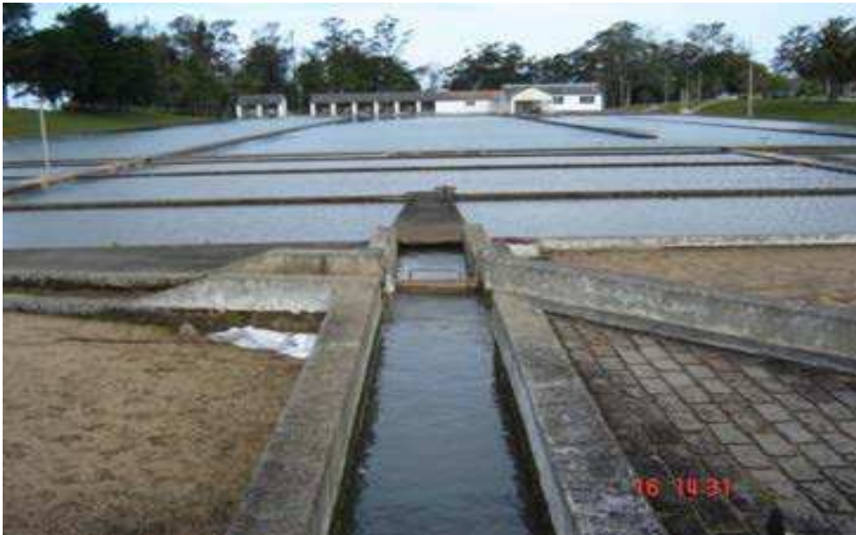
Ilustração 24 - Pré-filtros e decantadores
