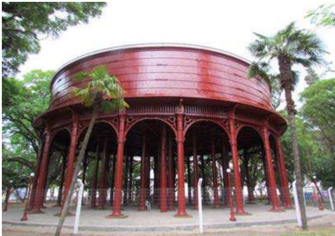
Ilustração 05 – Vista frontal do Reservatório R1.
