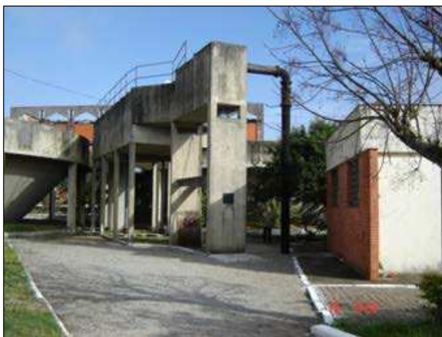
Figura 15 - Vista da estrutura de entrada (desarenador e Calha Parshall), com os dois reatores ao fundo. (Fonte STE)
