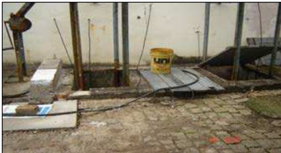
Figura 11 - Chegada do efluente na ETE (Fonte STE)
