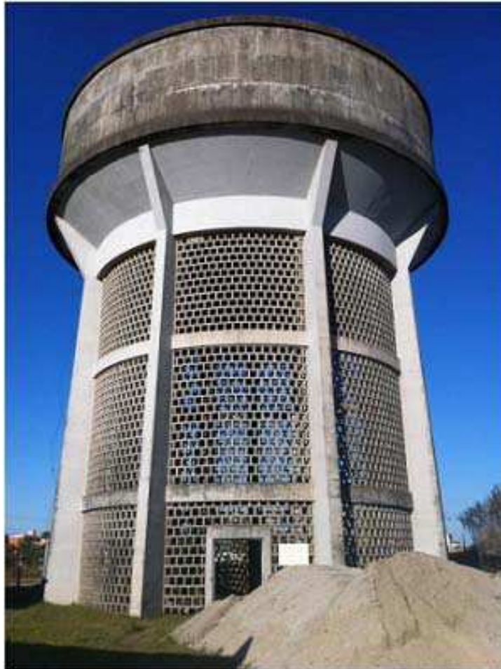
Ilustração 04 – Vista frontal do Reservatório R8.
