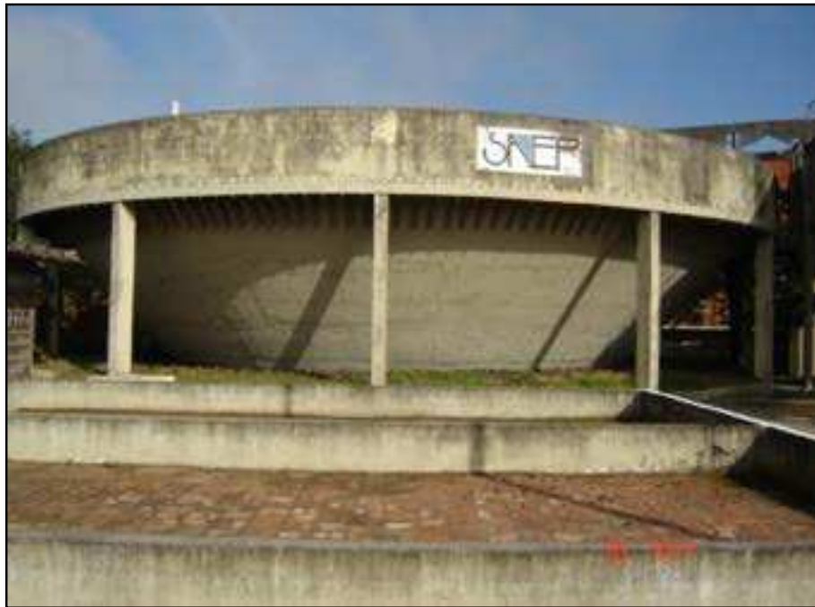
Figura 16 - Vista de um dos reatores (Fonte STE)
