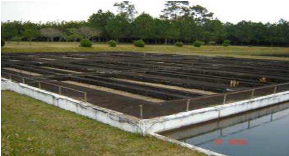
Ilustração 08 - Antigos filtros horizontais
