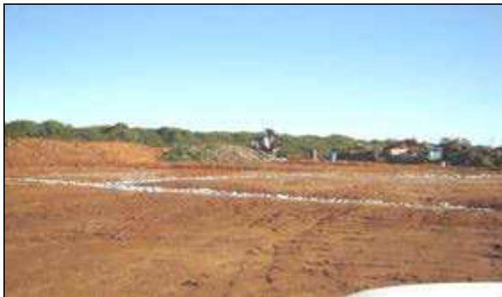
Foto 3.5 – Lançamento do sistema de drenagem de chorume
