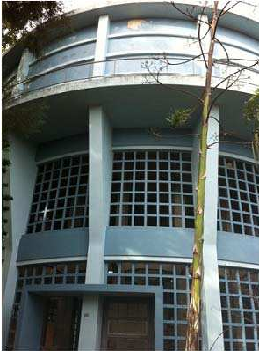
Ilustração 02 – Vista frontal do Reservatório R4.
