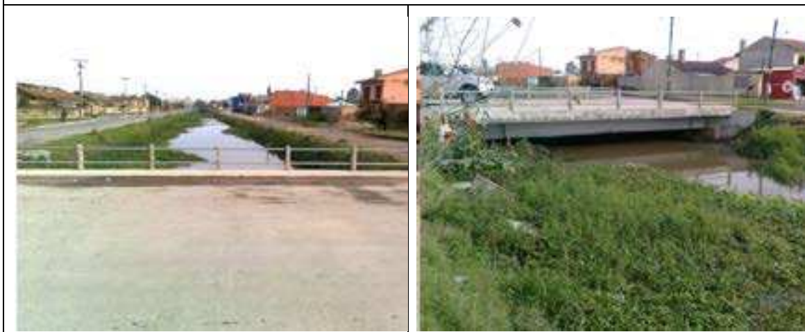
Figura 16: Prolongamento da Avenida Bento Gonçalves
