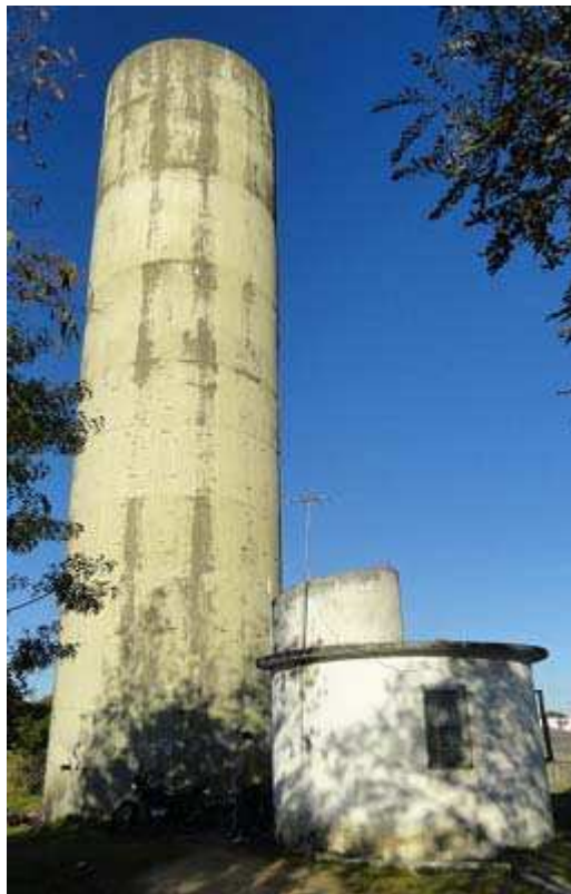
Ilustração 08 – Vista frontal do Reservatório Lindóia.
