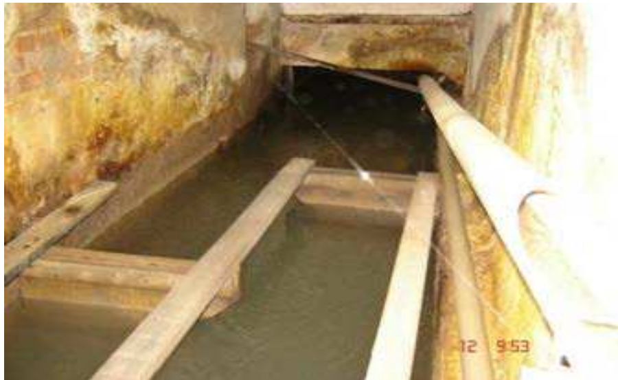
Ilustração 6 – Calha de mistura com chicanas
